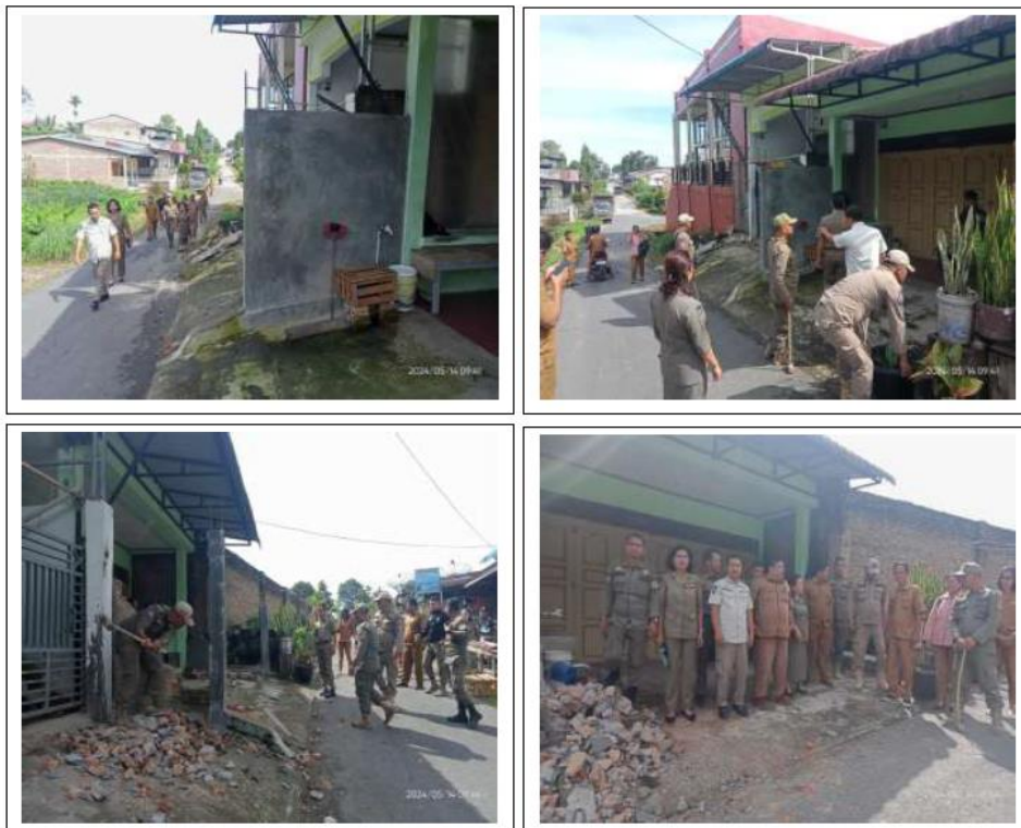
Melaksanakan pembongkaran tembok yang menyalahi aturan
