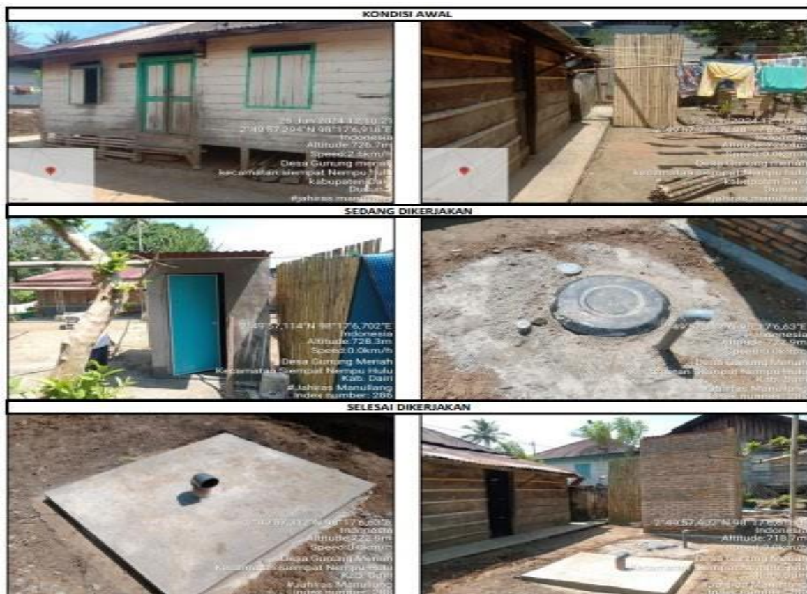
Pembangunan tangki septik skala individual perkotaan minimal 50 KK di desa Gunung Meriah Kecamatan Siempat Nempu Hulu
